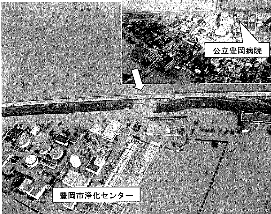
◀ 円山川左岸 9.6km 付近 一日市の堤防欠損 (国土交通省撮影)
