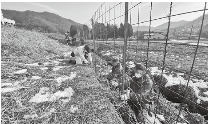
防護柵裾部分の補強作業
