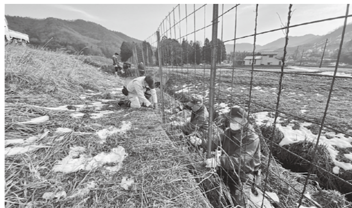
防護柵裾部分の補強作業
