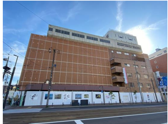
閉店したままの大規模商業施設
