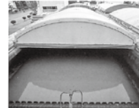
③最初沈殿池
