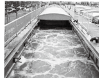
④エアレーションタンク
