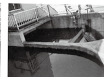
⑥塩素混和池
