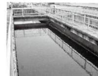
⑤最終沈殿池
