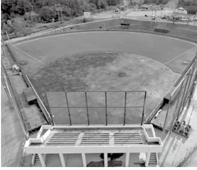
▲新しくなった出石総合スポーツセンター野球場
