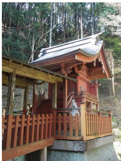
【本殿】基礎の補強、腐朽部材の取り替え及び紅柄塗装修理等
