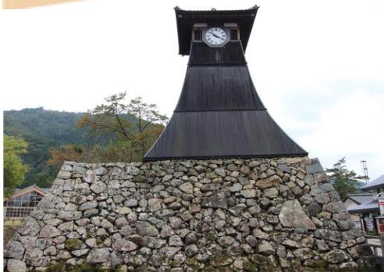
腐朽部材・外壁板の取替え修理及び構造補強、石垣間詰補修▶
