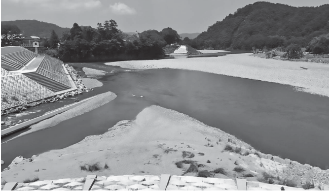
少しずつ、でも着実に工事が進む治水事業（浅倉付近）
