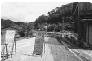
8月30日に発生した高潮により通行止めとなった県道竹野久美浜線(楽々浦地内)
