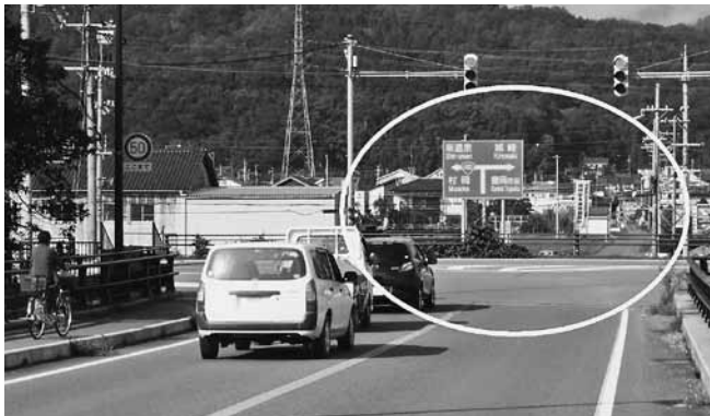
鶴岡橋から鶴岡第2期工事区間を望む
