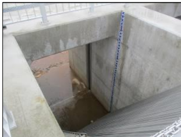
吸水槽施工完了状況
