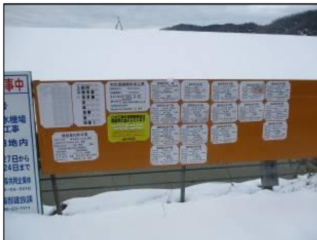
施工体系図等掲示物掲載状況
