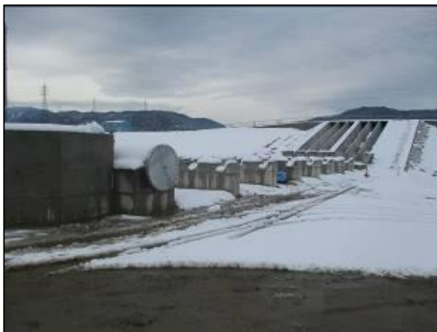
施工箇所全景
