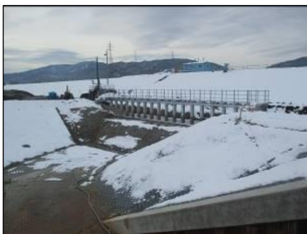
流入水路護岸工施工状況
