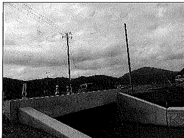
(新設函渠、上流側取付工及びバリケードと看板)
