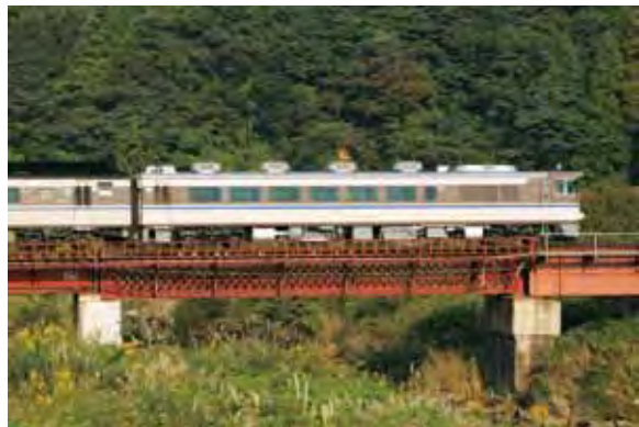
⑨ラチス桁橋（JR山陰本線竹野川橋梁）
